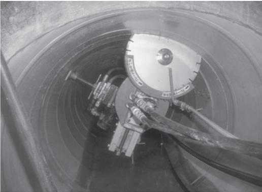
写真-4 複合管（ダンビー工法）への施工状況（マグマロック設置完了）
