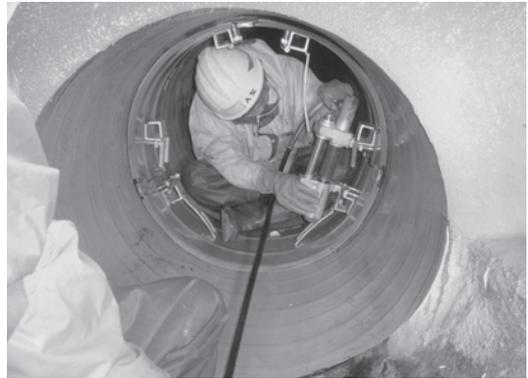
写真-6 複合管（SPR工法）への施工状況（マグマロック設置完了）
